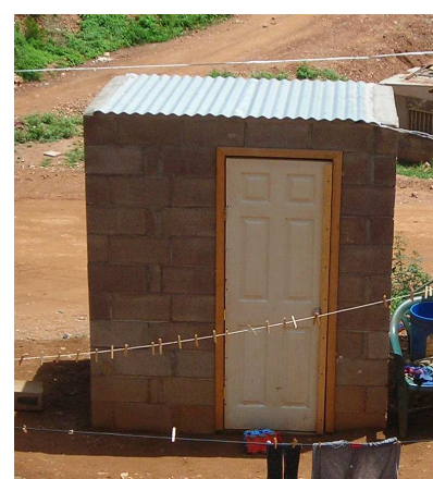
Sanitarios Fuera de la Casa
